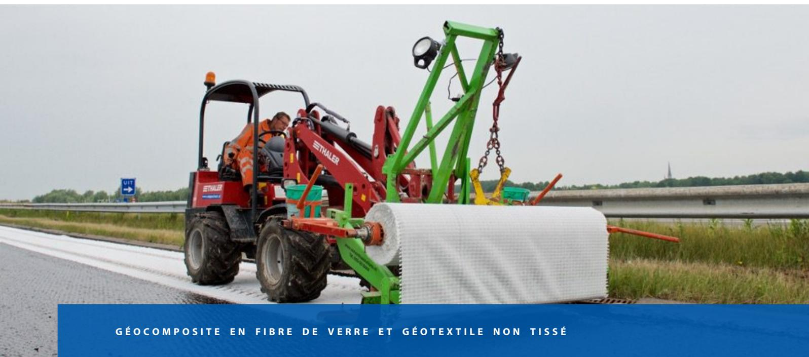
GÉOCOMPOSITE EN FIBRE DE VERRE ET GÉOTEXTILE NON TISSÉ
