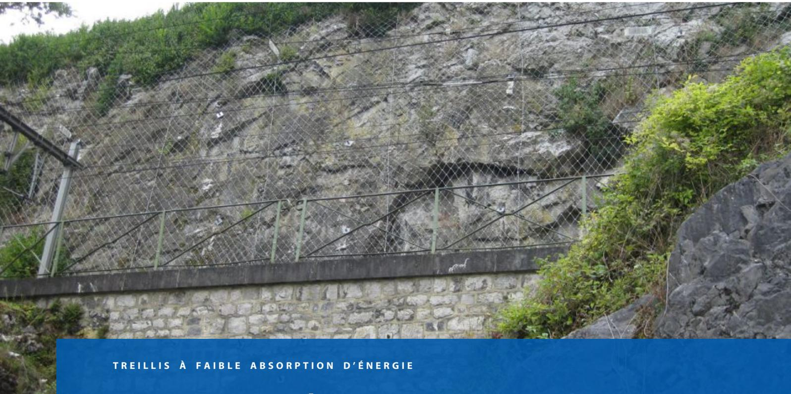
TREILLIS À FAIBLE ABSORPTION D'ÉNERGIE
