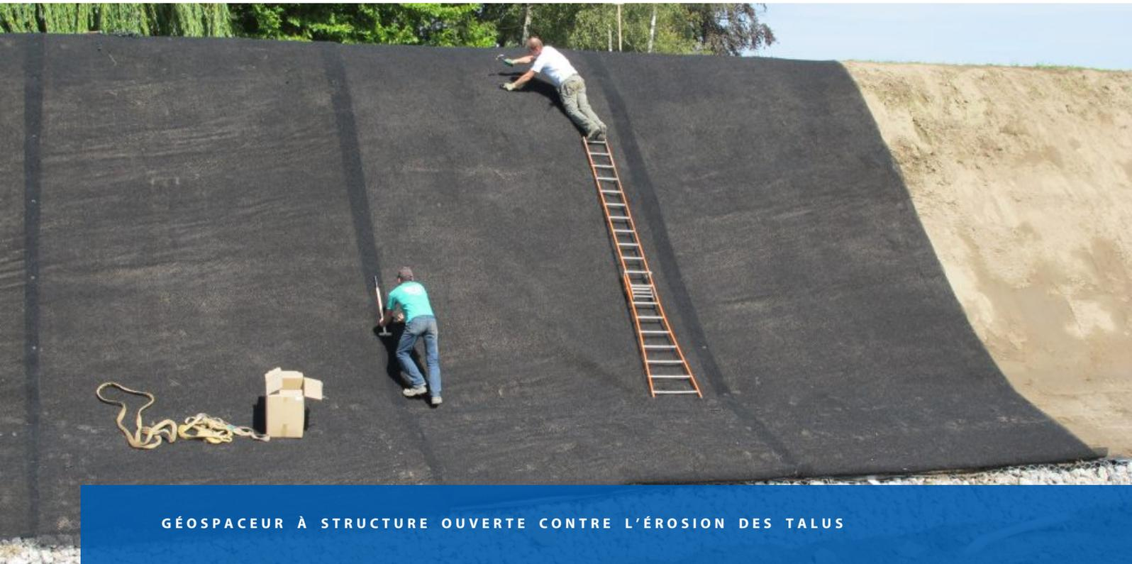
GÉOSPACEUR À STRUCTURE OUVERTE CONTRE L'ÉROSION DES TALUS
