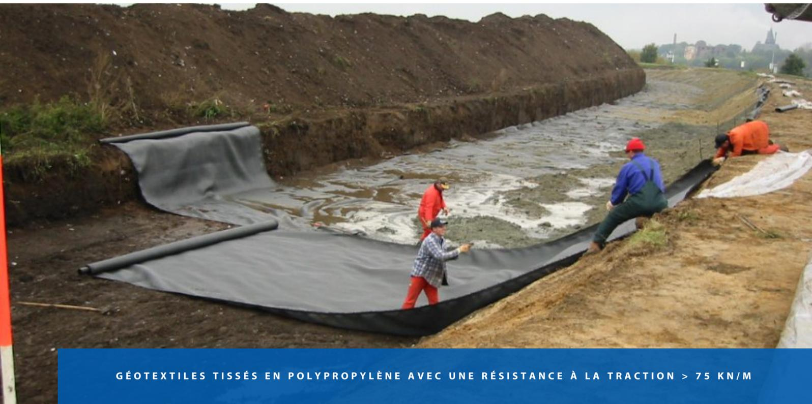
GÉOTEXTILES TISSÉS EN POLYPROPYLÈNE AVEC UNE RÉSISTANCE À LA TRACTION > 75 KN/M
