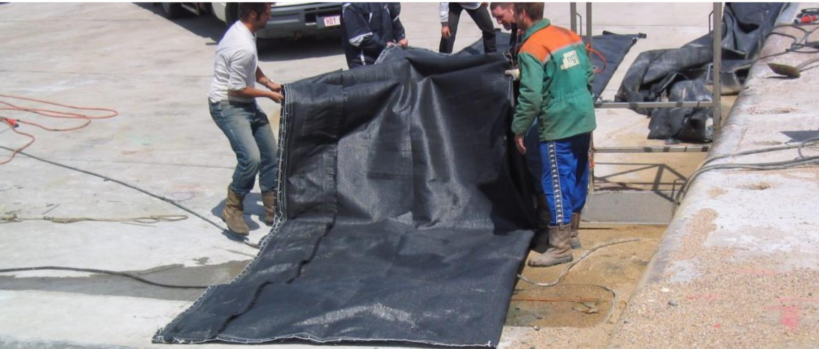
COFFRAGE POUR COULER UN BÉTON SOUS L'EAU
