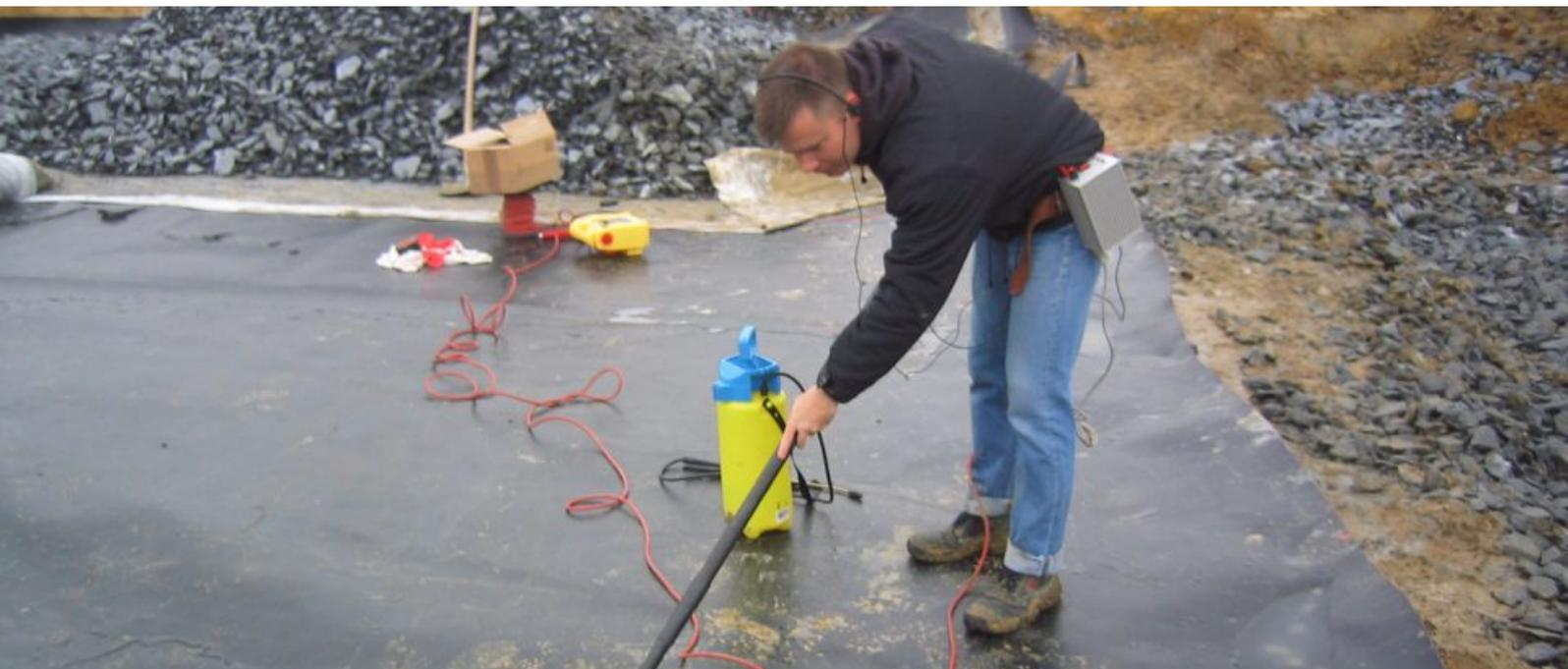
DÉTECTION MANUELLE DES FUITES DE LA SURFACE D'ÉTANCHÉITÉ
